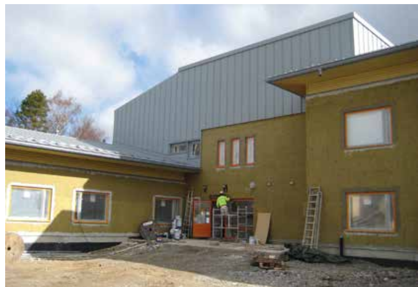
Hoivakoti Riihivainion rakennustyömaa.
