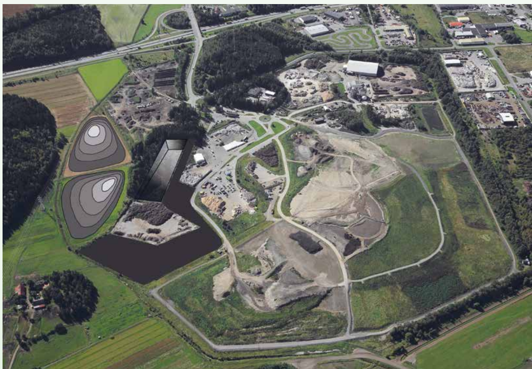
Kalliovaraston louhinnassa muodostuvalla murskeella rakennetaan pohjaa asfaltoitavalle varastokentälle. Osa murskeesta välivarastoidaan kahdessa pyramidissa myöhempää käyttöä varten.
