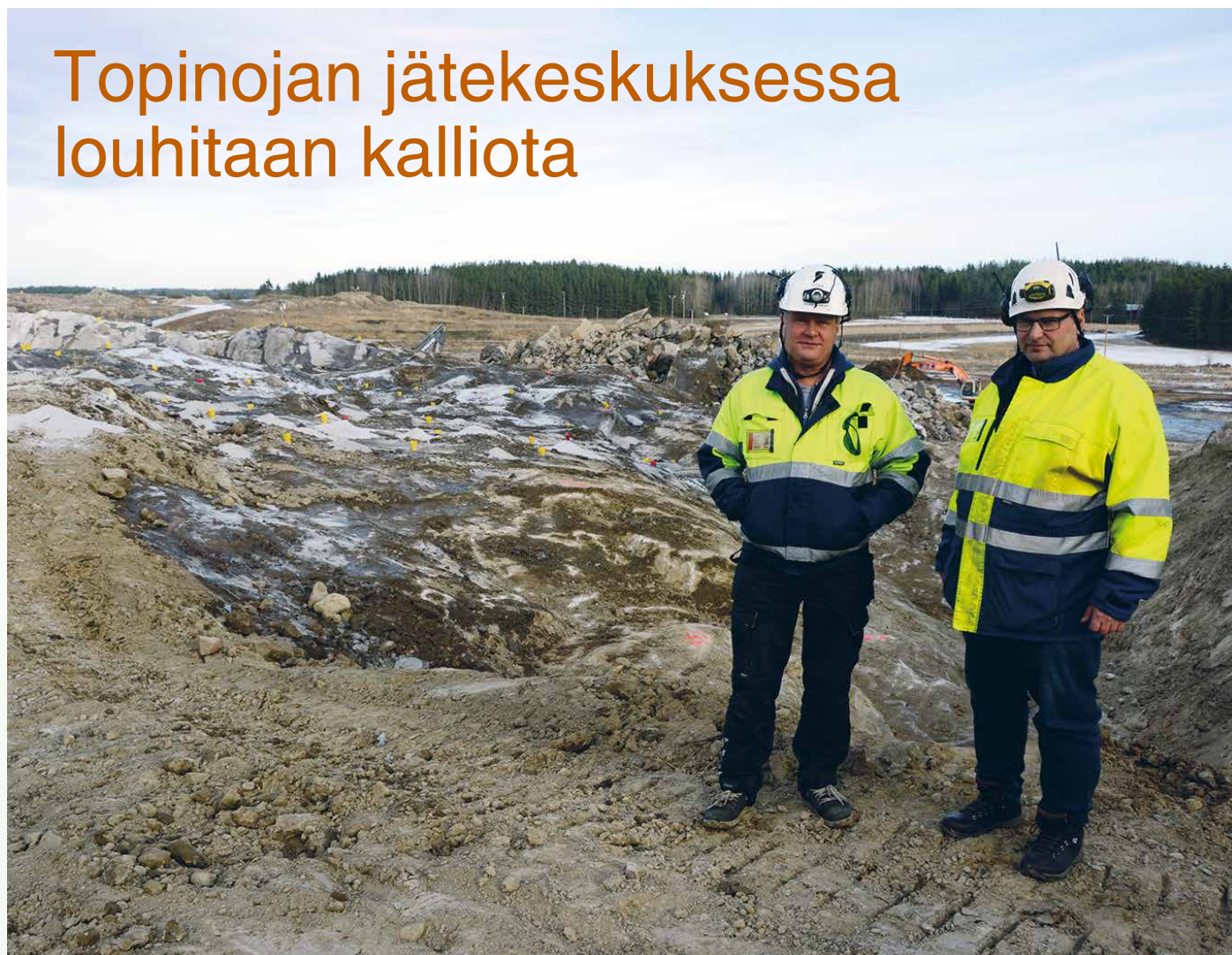
Työpäällikkö Kristian Nyström (vas.) ja louhintavastaava Jyri Lehmuskoski tulevan varastobunkkerin työmaan itäreunalla.
