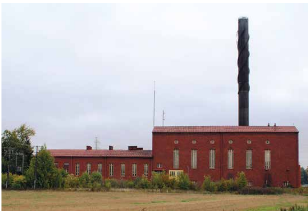
Vuodesta 1929 lähtien energiaa välittänyt Koroisten sähköasema siirtyi Turun kaupungin omistukseen 1985.
