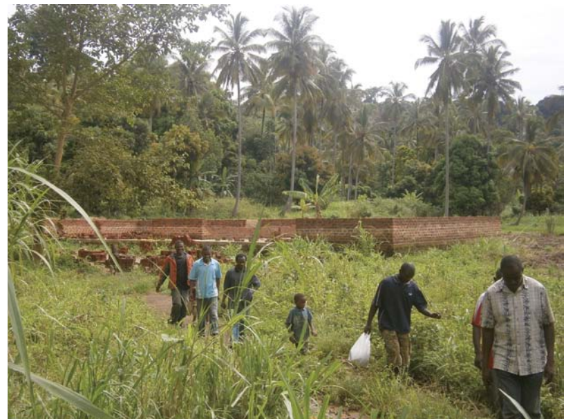
Kyläkehittämisohjelman tuotos: terveysasemaa ollaan rakentamassa.
