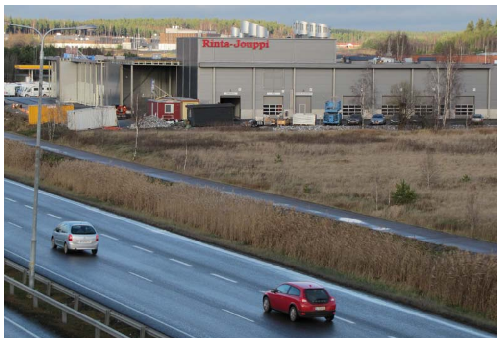
Rinta-Joupin Autoliikkeen laajennustyömaa Ohikulkutien varressa on enää viimeistelyä vaille.
