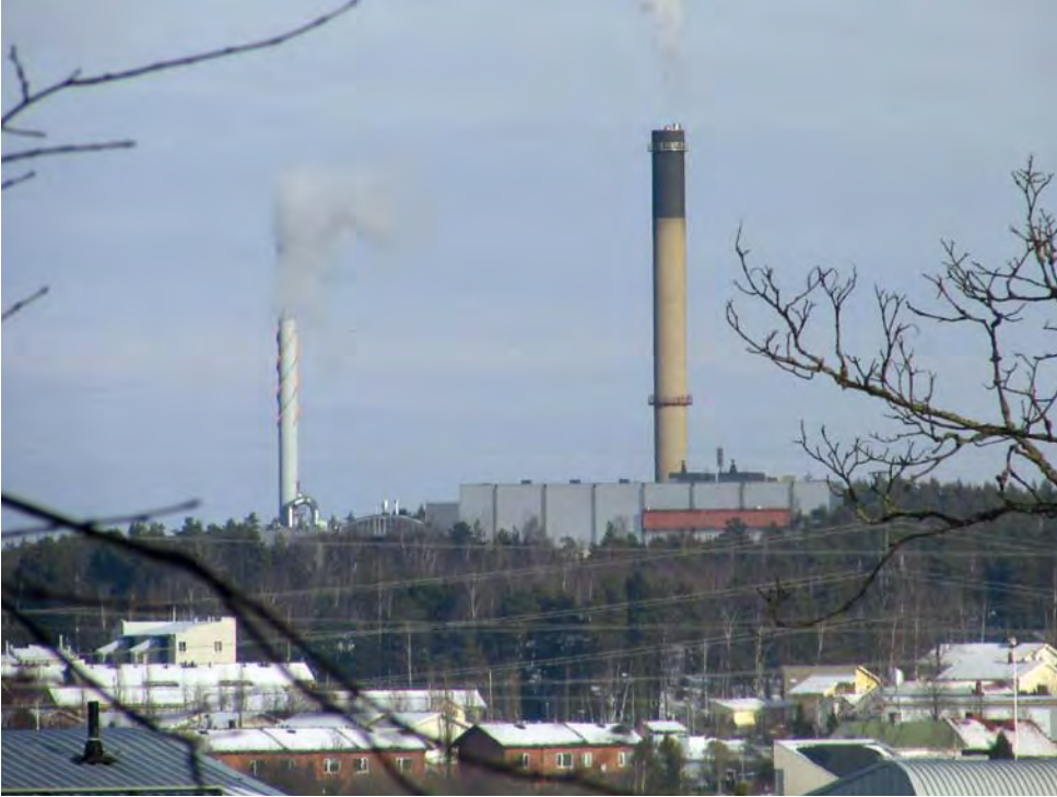
Biopolttolaitos eli Orikedon lämpökeskus (vas.) ja jätteenpolttolaitos kohoavat mäen päällä.
