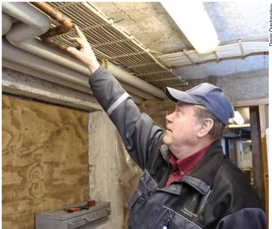
Pitkään jatkuneet kovat pakkaset laittoivat Koroisten talon putkiston koetukselle. Ilari Luojola näyttää halki mennyttä putkea, joka sulatettiin sähkökaapeleiden avulla.
